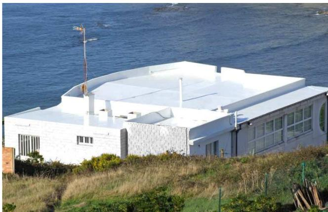
Membrana continua, elástica, resistente a la intemperie y de excelente adherencia. No precisa de armadura a base de mallas o fieltros (geotextil), salvo en puntos singulares (cantos, aristas, etc.).
